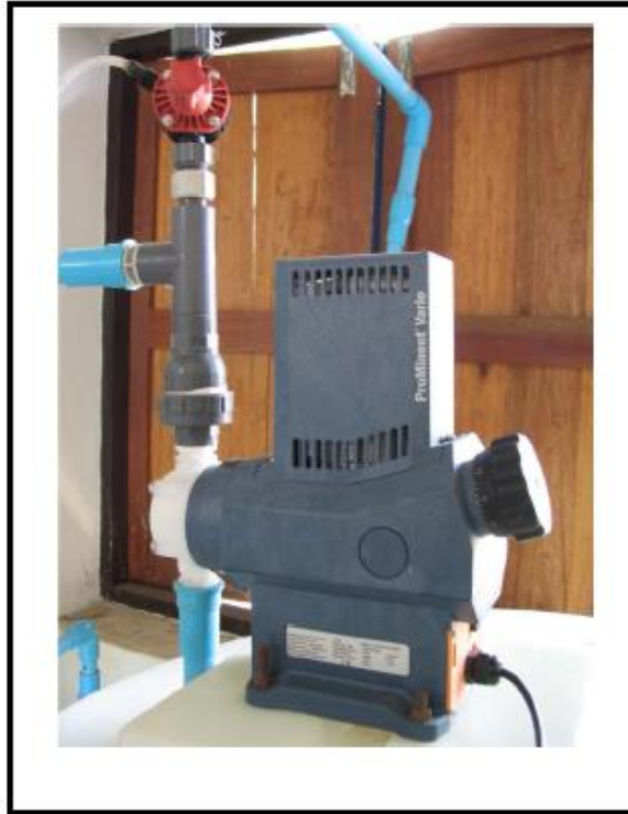
รูปที่ 29 รายละเอียดของเครื่องจ่ายสารละลายสารส้ม
