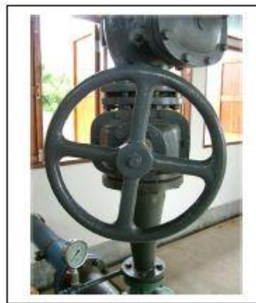
รูปที่ 37 ปิดประตุน้ำด้านท่อจ่ายน้ำของเครื่องสูบน้ำดิบ
