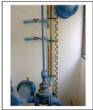
รูปที่ 45 หลอดวัดความฝืดถึงกรองน้ำ
