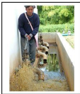
รูปที่ 61 เปิดประตูน้ำระบายตะกอน ข้างถังตกตะกอน ( ประตูน้ำหมายเลข 6)
