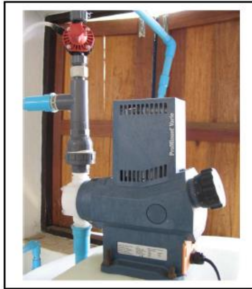
รูปที่ 32 รายละเอียดของเครื่องจ่ายสารละลายคลอรีน
