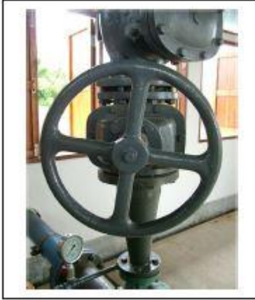
รูปที่ 56 ปิดประตูน้ำที่ช่องทางส่งของเครื่องสูบน้ำดี
