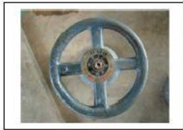
รูปที่ 43 เปิดประตูน้ำใส (ประตูน้ำหมายเลข 3 )
