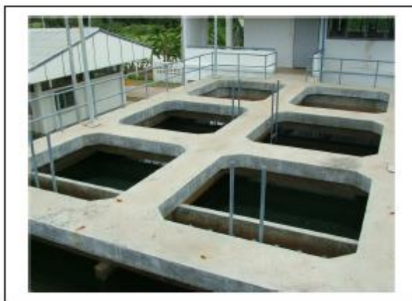
รูปที่ 24 ถังตกตะกอน
