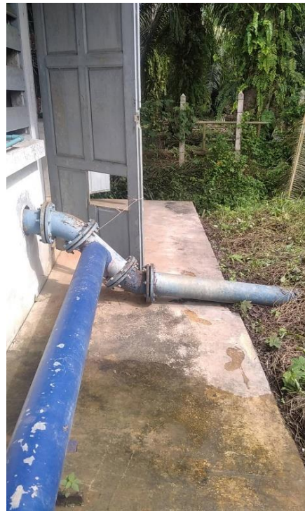
รูปที่ 2. ท่อส่งน้ำดิบจากโรงสูบน้ำไปบ่อดกตะกอน
