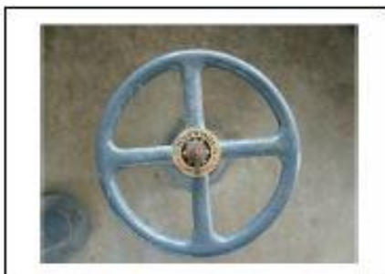
รูปที่ 46 ปิดประตูน้ำเข้ากรอง (ประตูน้ำหมายเลข 9)
