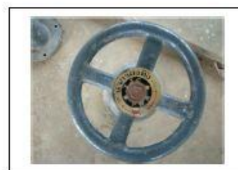
รูปที่ 42 เปิดประตูน้ำกรองทิ้ง (ประตูน้ำหมายเลข 4)
