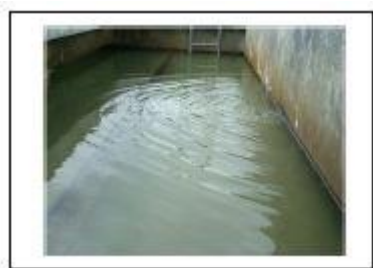
รูปที่ 53 การเกิดตะกอนในถังรวมตะกอน
