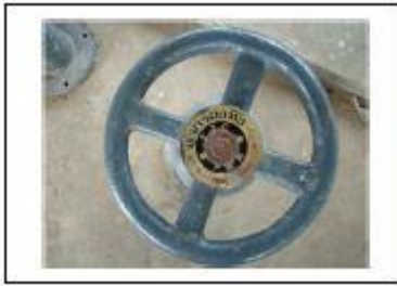
รูปที่ 51 เปิดประตูน้ำกรองทิ้ง (ประตูน้ำหมายเลข 4)
