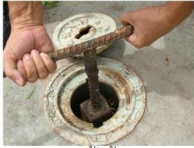
รูปที่ 59 เปิดประตูน้ำจ่ายน้ำประปา (ประตูน้ำหมายเลข 1)
