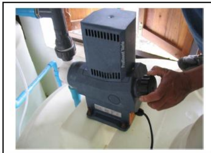
รูปที่ 33 การปรับอัตราการจ่ายสารละลายคลอรีนที่ประมาณ 80%
