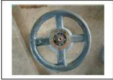
รูปที่ 47 ปิดประตูน้ำใส (ประตูน้ำหมายเลข 3)
