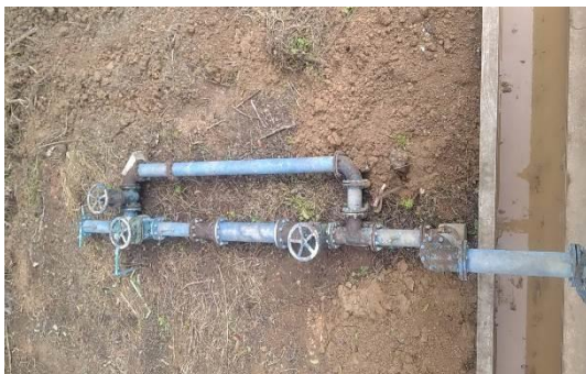
รูปที่ 19 ท่อกวน (Inline Static mixer)
