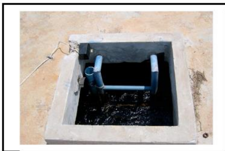
รูปที่ 28 สวิทช์ลากลอยในถังน้ำใส
